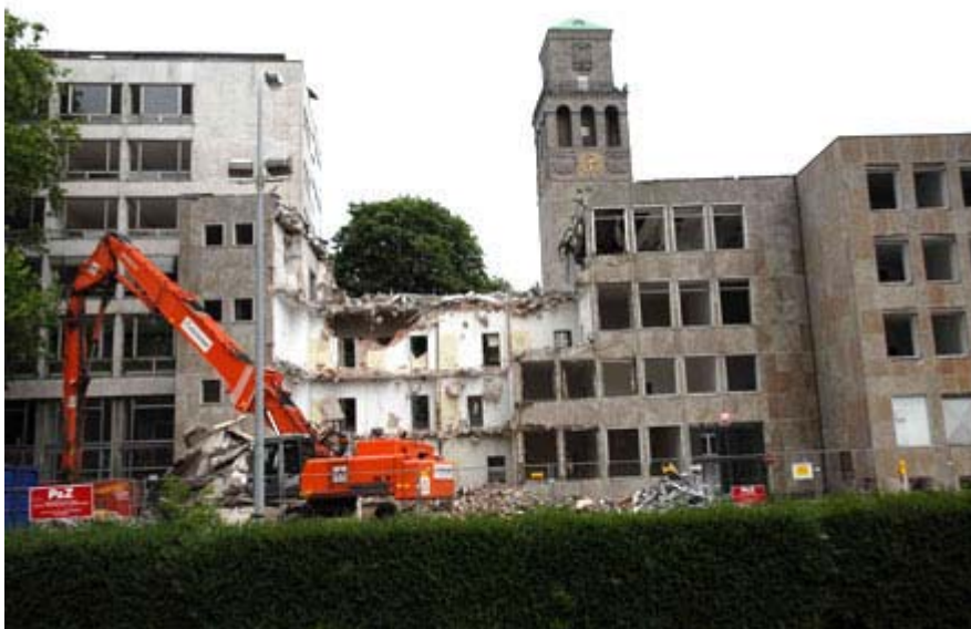
Teil des Planungstrümmerfelds – das alte Rathaus wird abgerissen Quelle: MBI-Archiv
