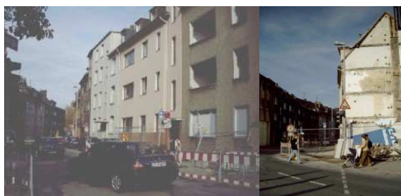
Wie im Bild rechts sah der Klöttchen bis Anfang 2009 aus, als auch das 2. Haus auf der rechten Seite abgerissen wurde.
