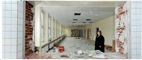
Luisenschule inmitten der Baustelle
